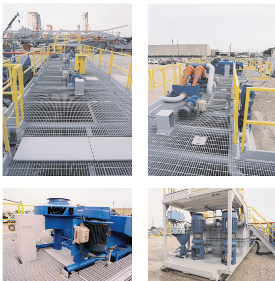
Équipements de contrôle des solides
