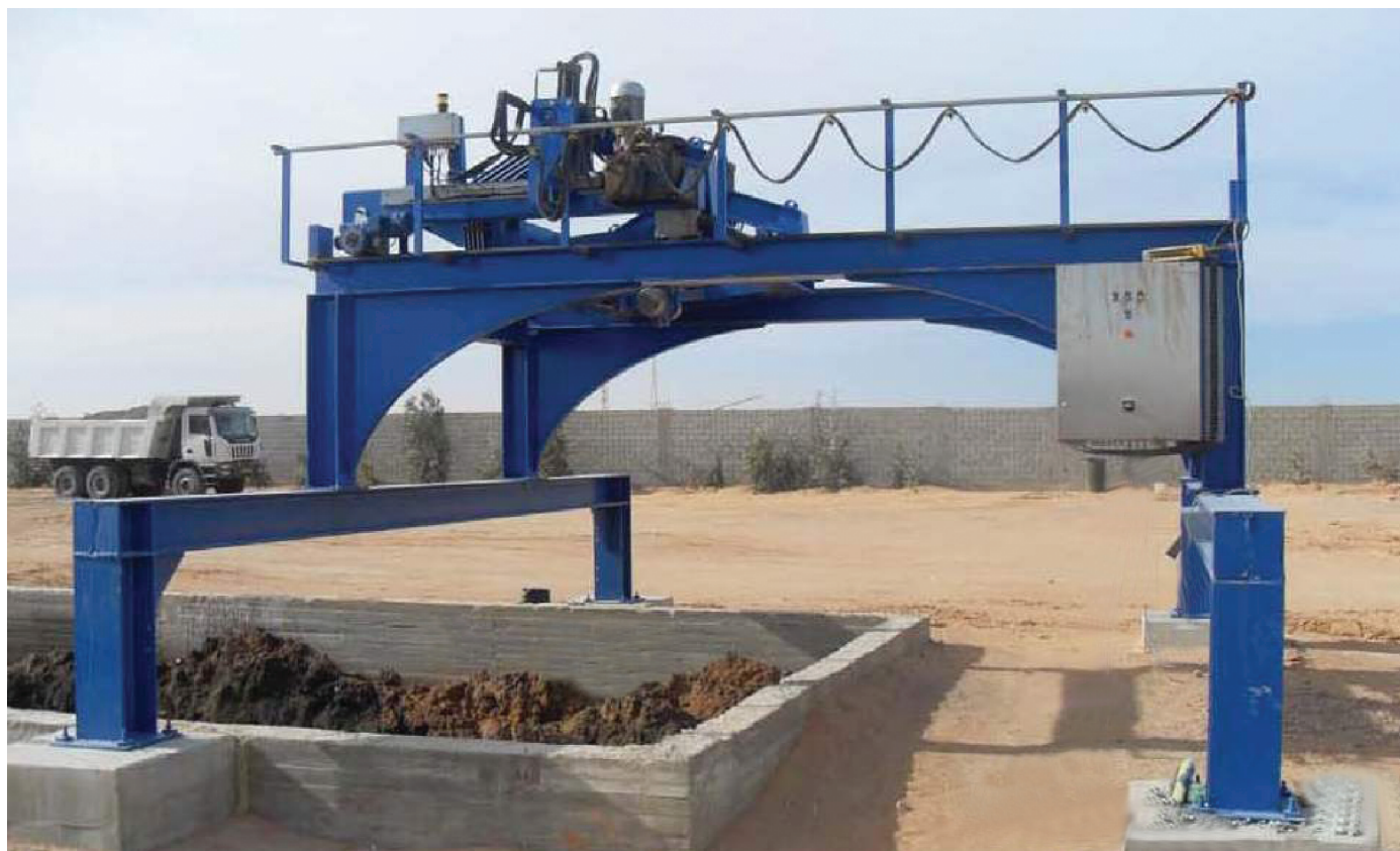
Tourneur de bennes installé au-dessus de la fosse « sous terre »
