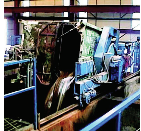
Tourneur de bennes de déblais
