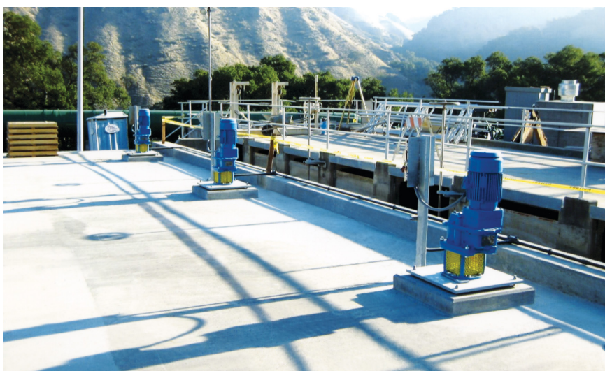
Модель 20 GT, установленная на предприятии по очистке сточных вод
